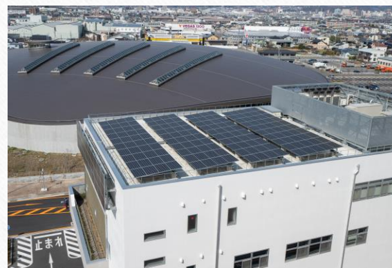
太陽光発電設備
