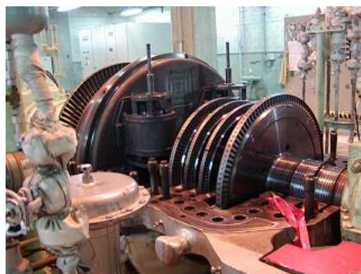
蒸気タービン開放点検
