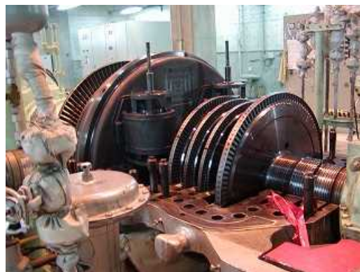
蒸気タービン開放点検
