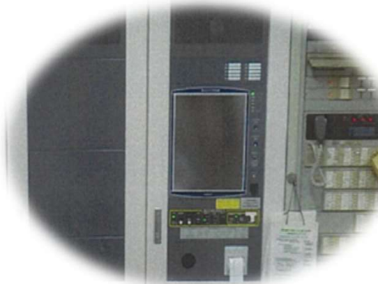
消防設備更新工事
