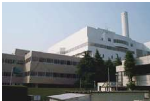
柳泉園 クリーンポート 平成12年11月稼働 105t×3炉
