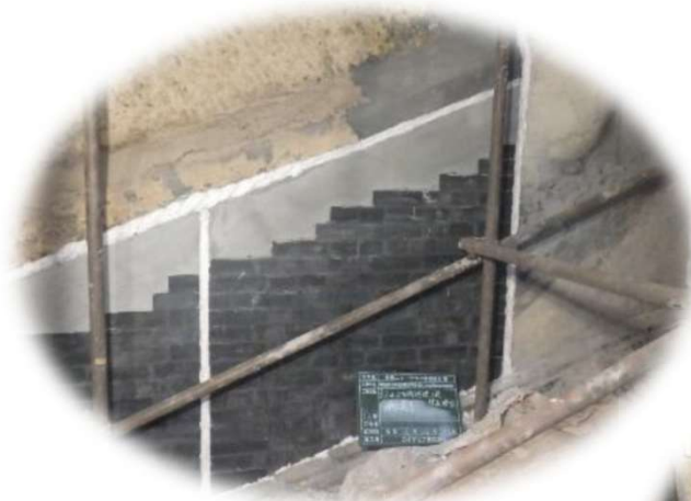
耐火物の補修
