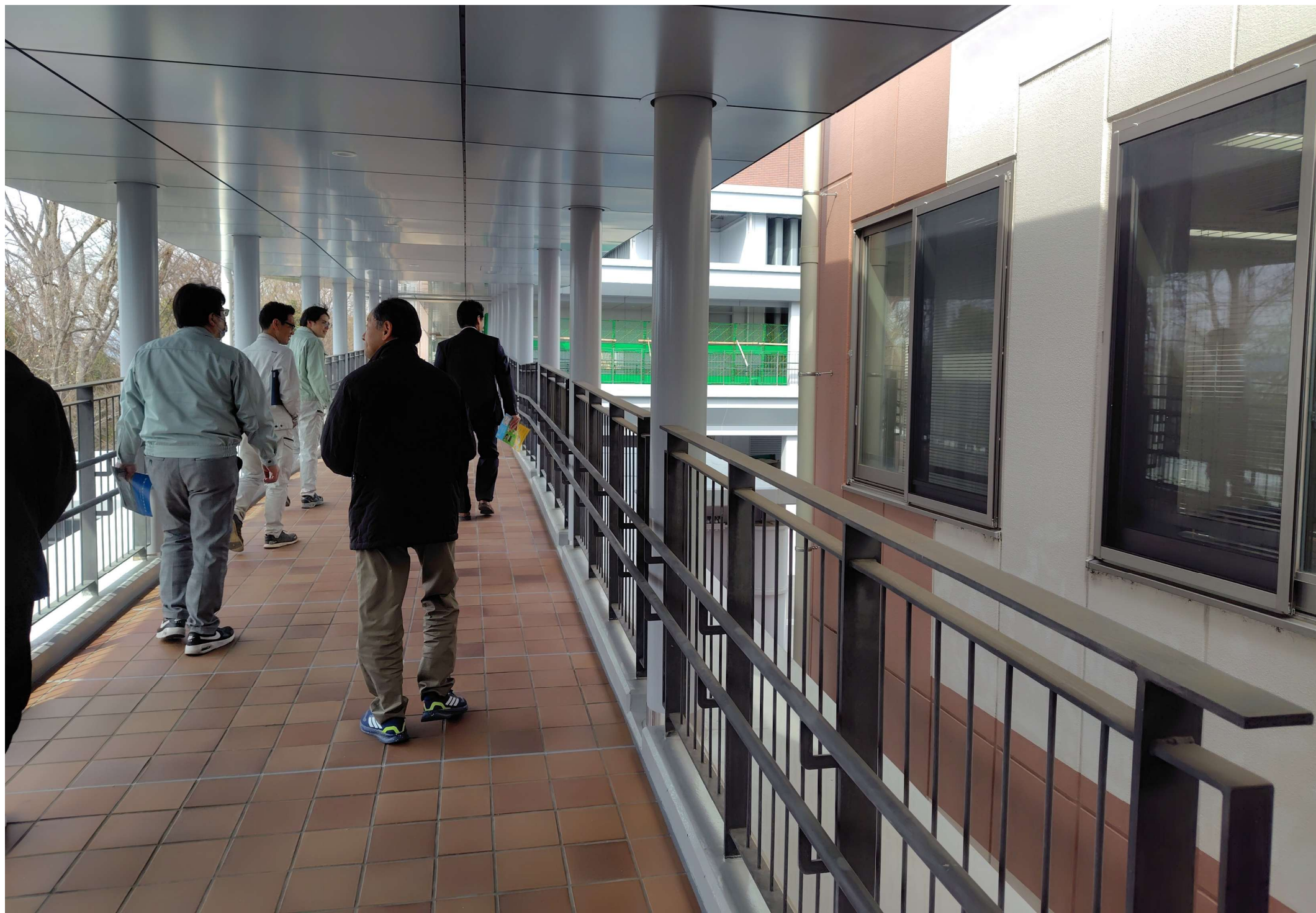
新焼却施設と不燃・粗大ごみ処理施設をつなぐ渡り廊下（増設）
