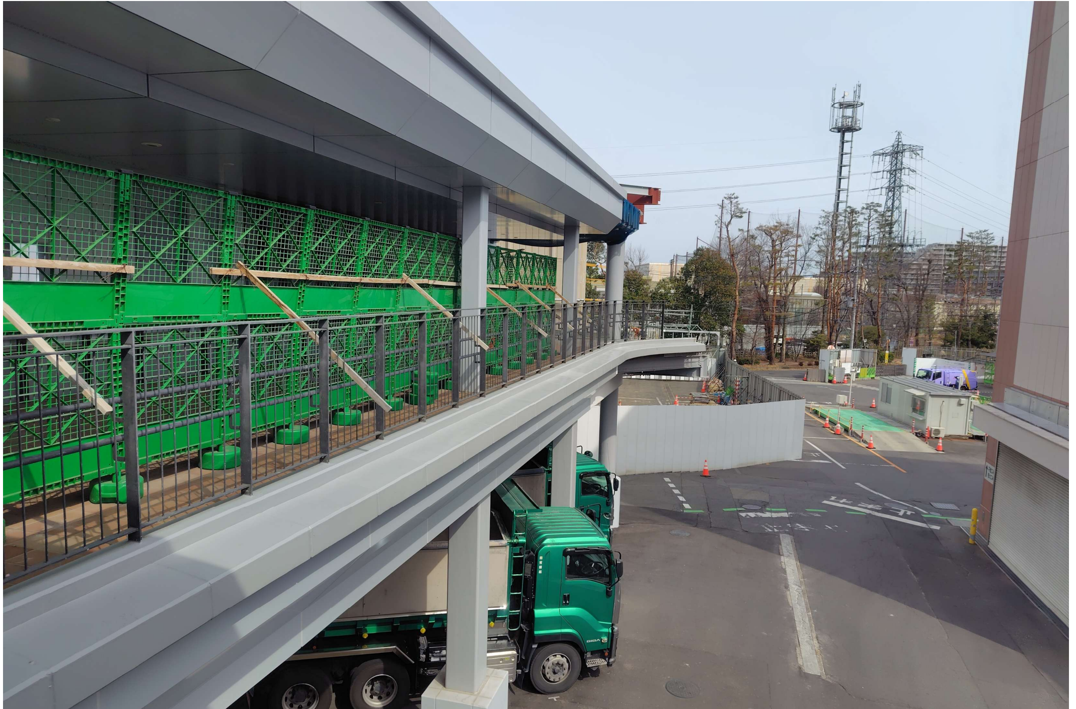
渡り廊下（建設中・建設中の管理棟へつながる予定）
