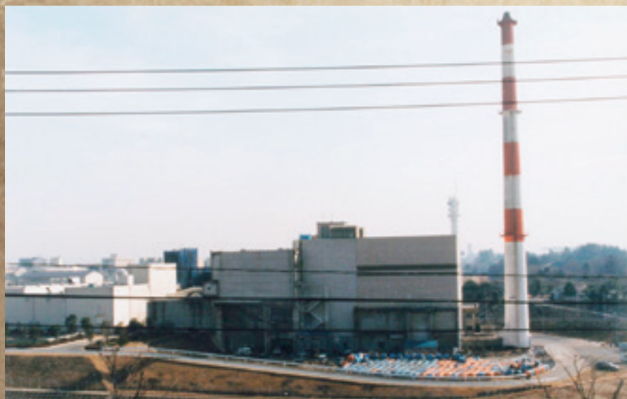
平成3年頃の旧清掃工場
